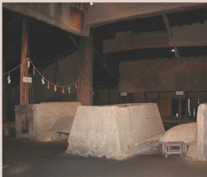
島根県飯石郡吉田村にある全国で現存する唯一のたたら建築(中央にあるのが製鉄炉)
