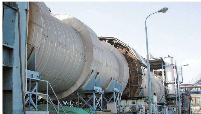
写真4（解体前）ロータリーキルン。直径 3.6 m × 長さ 36 m
