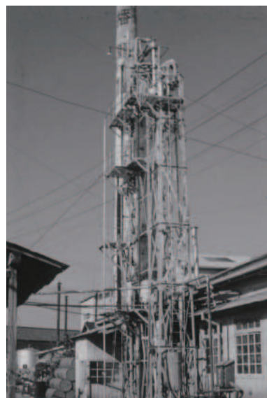
写真2 パイロットプラント（1957年に建設）
