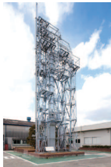
写真5 パイロットプラント（記念碑として2012年に移設）
