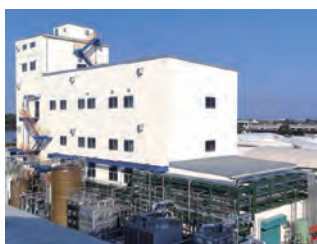
新プラント (2025.05竣工)
