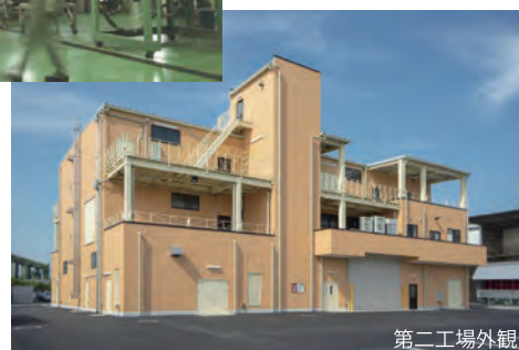
第二工場外観
