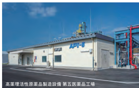
高薬理活性原薬品製造設備 第五医薬品工場
