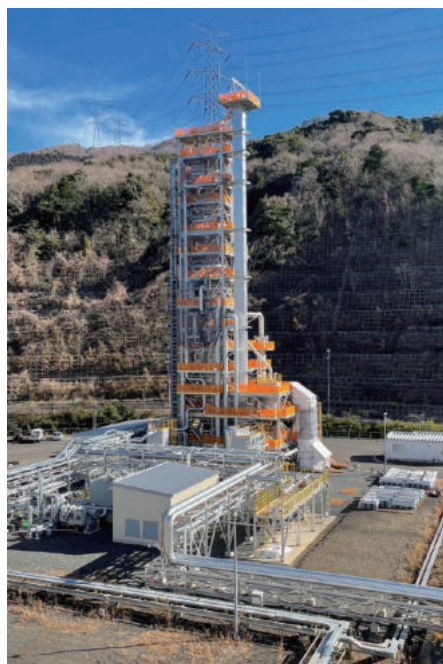
図2 パイロットスケール試験設備の外観
