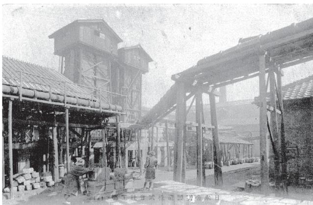
写真2 操業中の塩酸吸収塔(明治40年頃)
