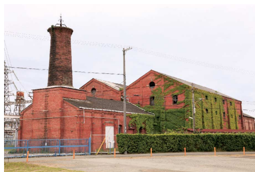
写真7 石炭ボイラー用建屋の現状(受電設備)
