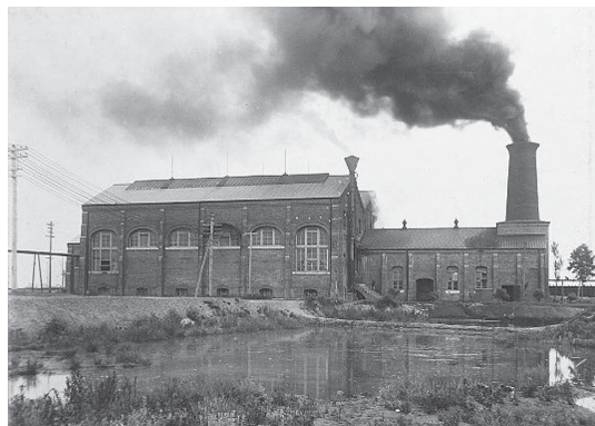
写真6 1909年完成の石炭ボイラー用建屋
