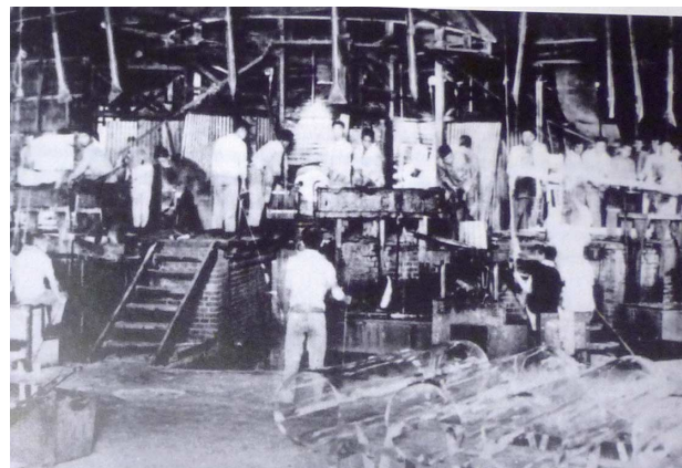
図1 連続蓄熱式タンク炉前の台上のガラス円筒吹き作業 1) 台の横にあるガラス円筒を振るための溝、手前には縦に開く前の円筒が並んでいるの見える。
