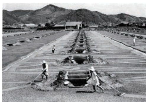
写真3 山口県防府市三田尻塩田の様子 (防府市教育委員会提供)
