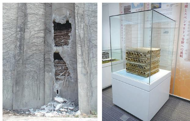
写真1（左）1961年から1973年まで操業した5号塔・2019年解体中の写真、（右）5号塔で使用されていた竹製液流分散材（認定化学遺産）
