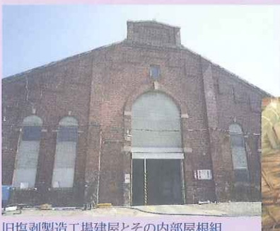
旧塩素製造工場建屋とその内部屋根組 (昭和電工(株)東長原事業所)
