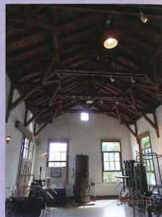
工場建屋内部 (1911年建造。1999年移築。 現日本酸素記念館)
