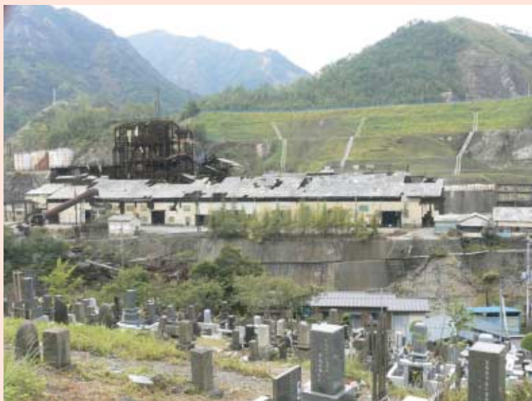
渡良瀬川対岸の龍蔵寺から望む解体中の製錬所（2009年秋）。龍蔵寺の墓地には、多数の足尾の関係者が眠っている。そして、2010年6月、解体はほぼ完了した。
